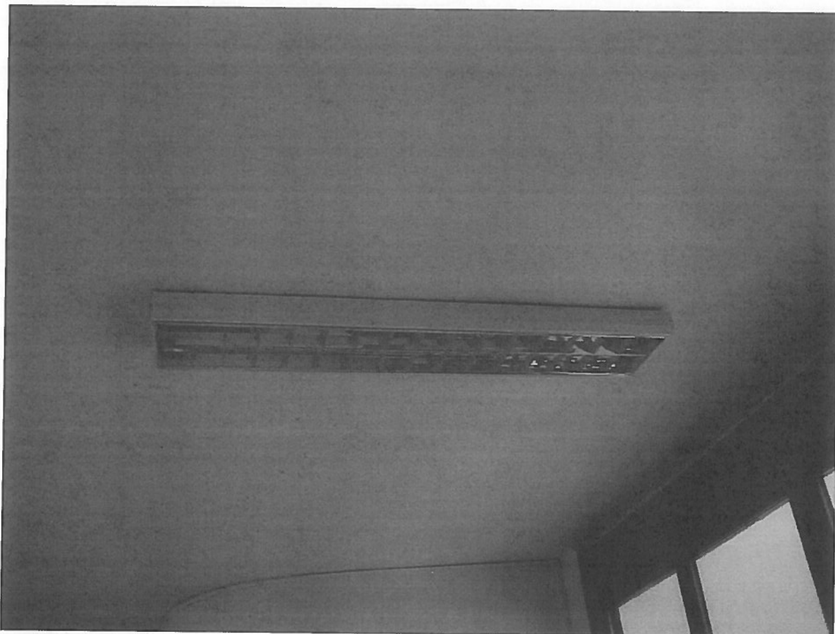
Zářivka trubice 2x36W elektronický předřadník 467ks svítidel
